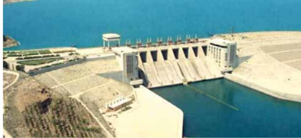
صورة تظهر سد الفرات بحالة إغلاق «بوابات الفيض» المعلقة حالياً مع استمرار تدفق المياه عبر العنق من أسفل البوابات (عن الانترنت)
