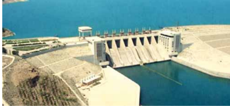
صورة تظهر سد الفرات بحالة إغلاق «بوابات الفيض» المعلقة حالياً مع استمرار تدفق المياه عبر العنق من أسفل البوابات (عن الانترنت)
