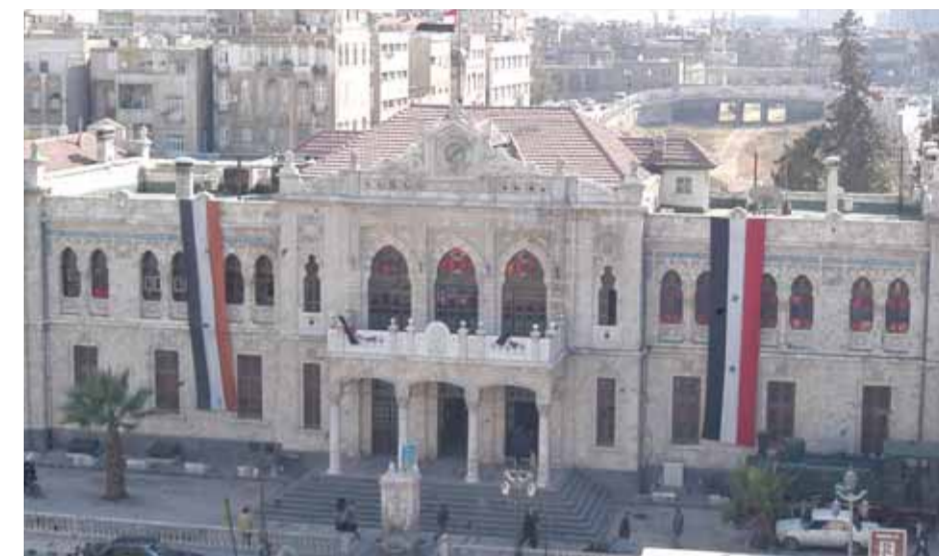
محطة الحجاز أم أعمال «أراندا» المعمارية الباقية في دمشق
