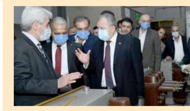
الصالحين على هامش جولته لتفقد تأهيل المجموعتين الأولى والخامسة في المحطة الحرارية: إنه بتوجيه من الرئيس بشار الأسد بتأمين الكهرباء لمحافة حلب تم اتخاذ القرار بإعادة تأهيل المحطة من خلال التعاون مع الشركات الصديقة حيث تمت المباشرة بالعمل وستبدل جهود مضاعفة لوضع مجموعة المحطة بالخدمة نهاية العام الحالي أو بداية العام على أبعد حد.
