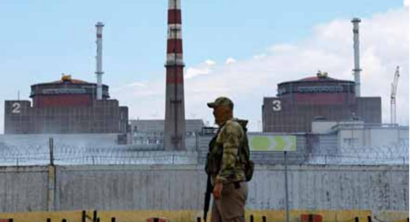
عودة التيار الكهربائي لمحطة زابورجيه النووية (عن الانترنت)
