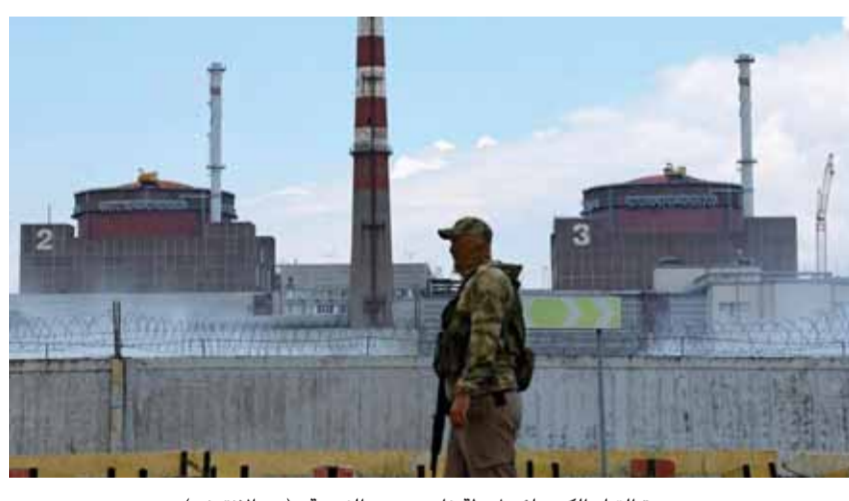
عودة التيار الكهربائي لمحطة زابورجيه النووية (عن الانترنت)
